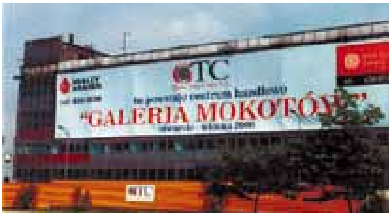
Warszawa, ul. Wołoska. Widok na halę fabryczną - pozostałość po Zakładach Elektronicznych CEMI. Na ich miejscu powstaje zagraniczny, wielki dom towarowy.
